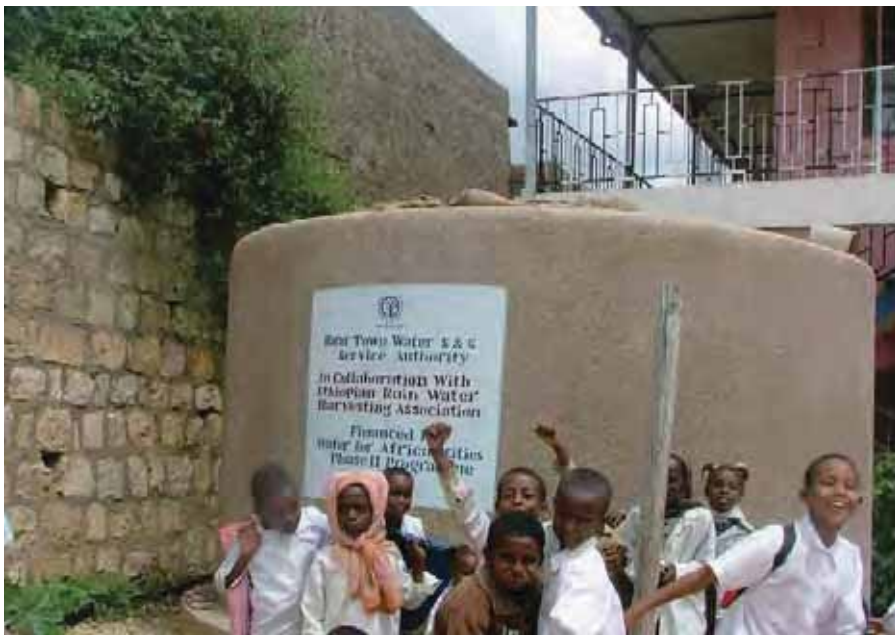
Новый резервуар для сбора дождевой воды в Эфиопии
