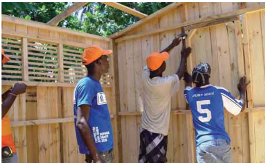
Свыше 200 добровольцев пока построили 30 домов
